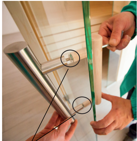
Kunststoff Beilagscheibe bei Niro-Griff beilegen
