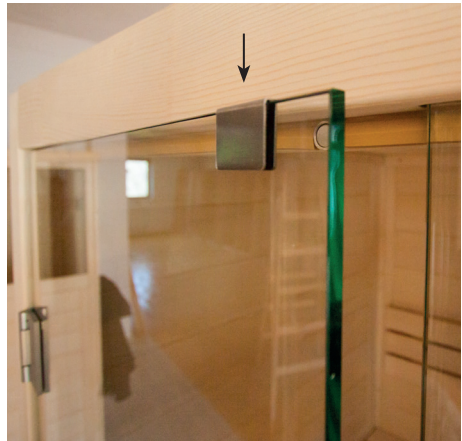
Kunststoff Beilagscheibe bei Niro-Griff beilegen
